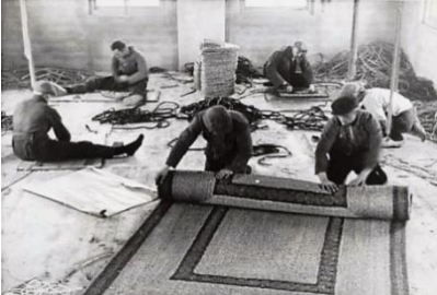
Het vlechten van de matten op een mal
