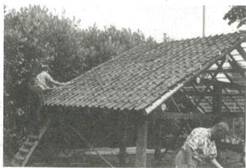
"Het werkhuis Sint Paulus" in aanbouw met 7 gordingen, panlatten en pannen rechts van het middenpad opslag in 4 verdiepingen, achterwand gepotdekseld
