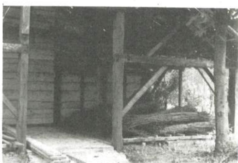
"Het werkhuis Sint Paulus" in aanbouw met 7 gordingen, panlatten en pannen rechts van het middenpad opslag in 4 verdiepingen, achterwand gepotdekseld
