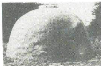
2 1/2 m leem is nodig geweest om de 1960 te bedekken. Geperforeerde buisjes dienen als ventileratie systeem.....
