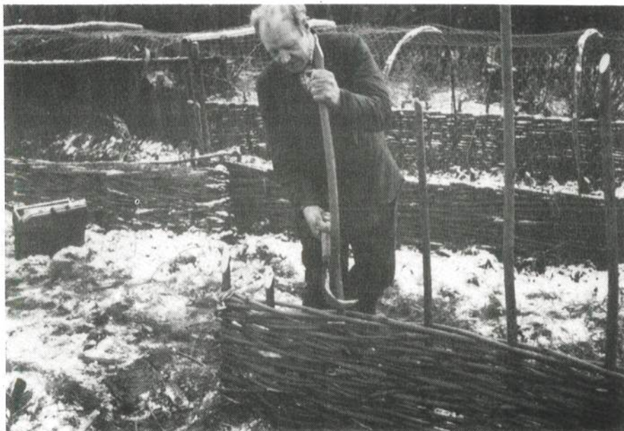
Als het breien klaar is, de horde zuiver maken met snoeimes of bandhaak.
